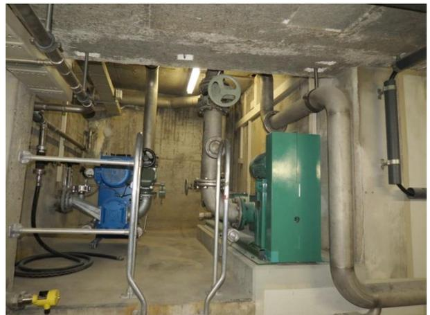
Abbildung 2: Frischschlammpumpe (rechts)
