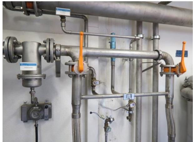
Abbildung 5: Rohrleitungen nach Gaskompressoren (Gasraum)
